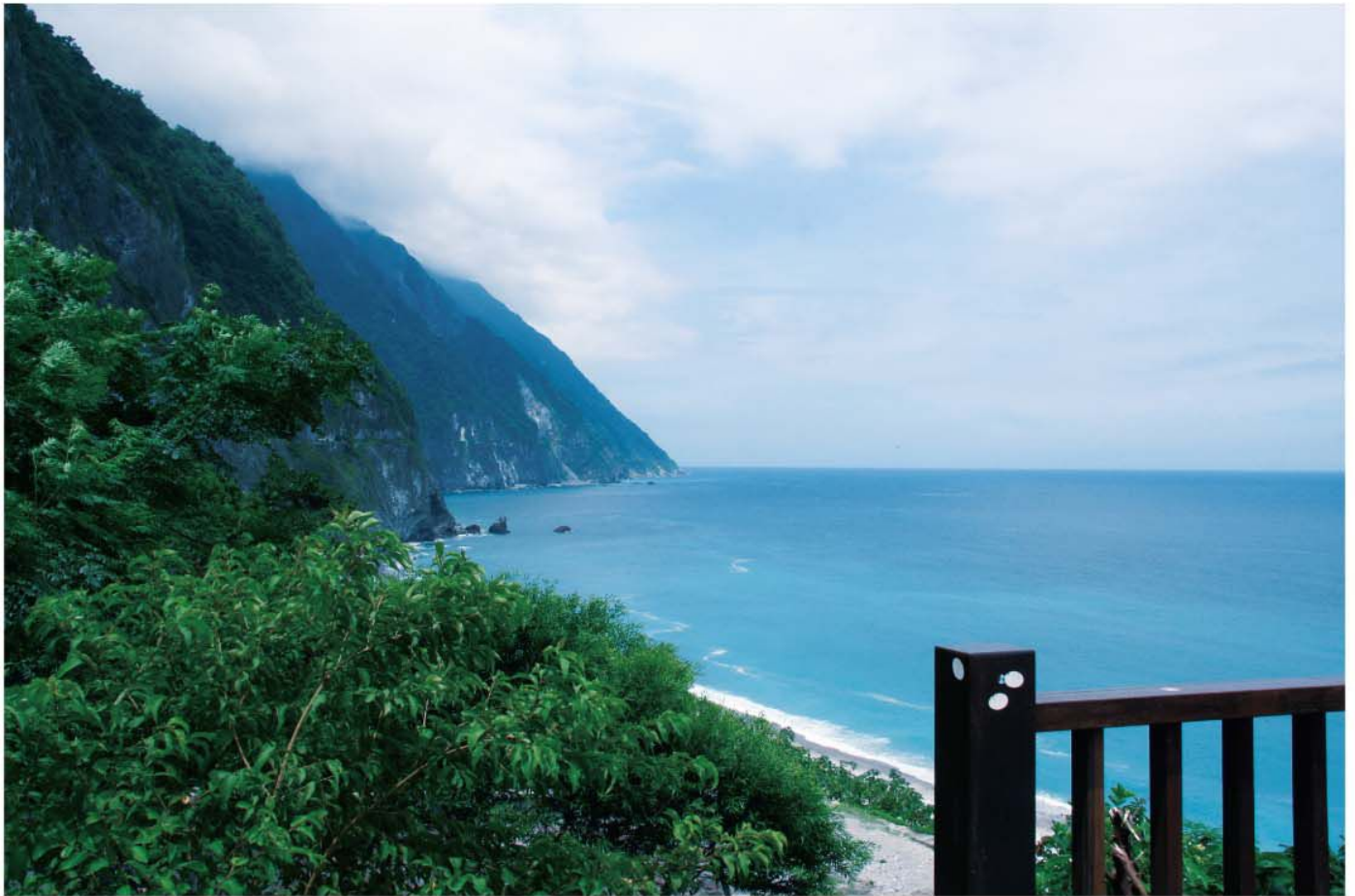
蘇花公路海天一色，美景天成，但在梅姬颱風過境時，豪雨造成蘇花公路嚴重坍塌，幸賴內政部空中勤務總隊救援，即時救出受困旅客。
