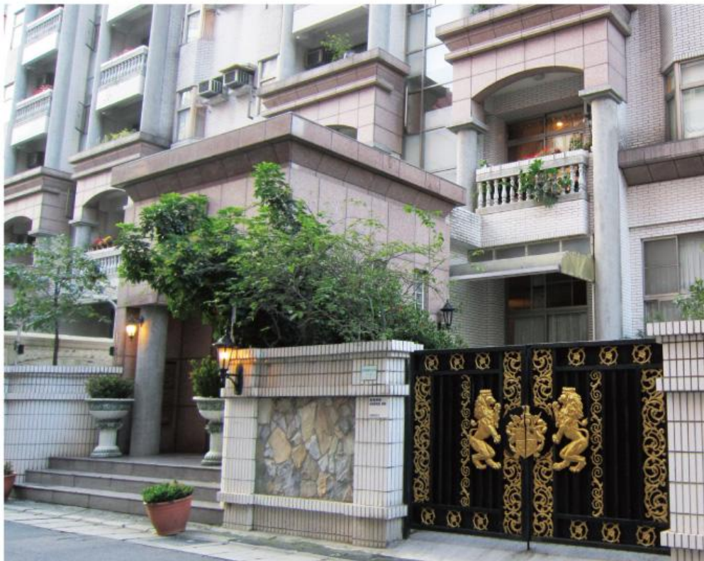
美侖美奐的家園首重高科技安全防護系統。
